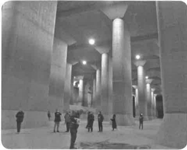
首都圏外郭放水路は首都圏の水害を軽減する目的で造られた治水施設で、春日部市内の国道16号直下約50mの地下に設けられた延長約6キロの世界最大級の地下放水路です。
